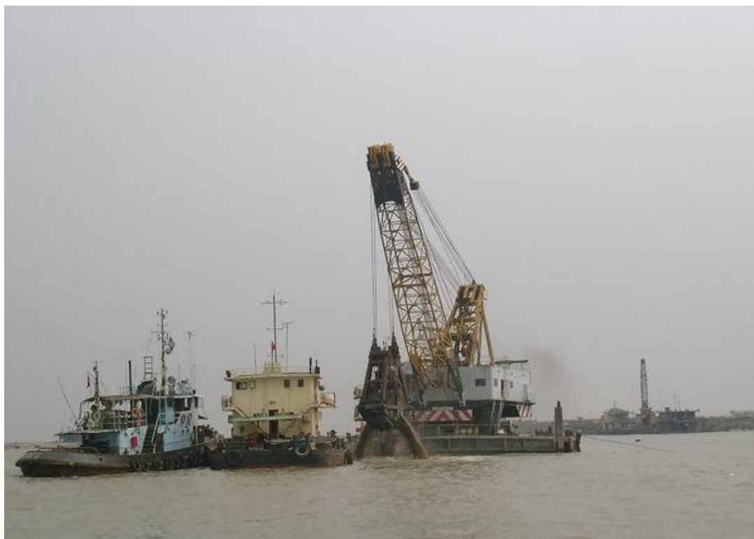
图 4.3.2-6 抓斗挖泥船施工图
