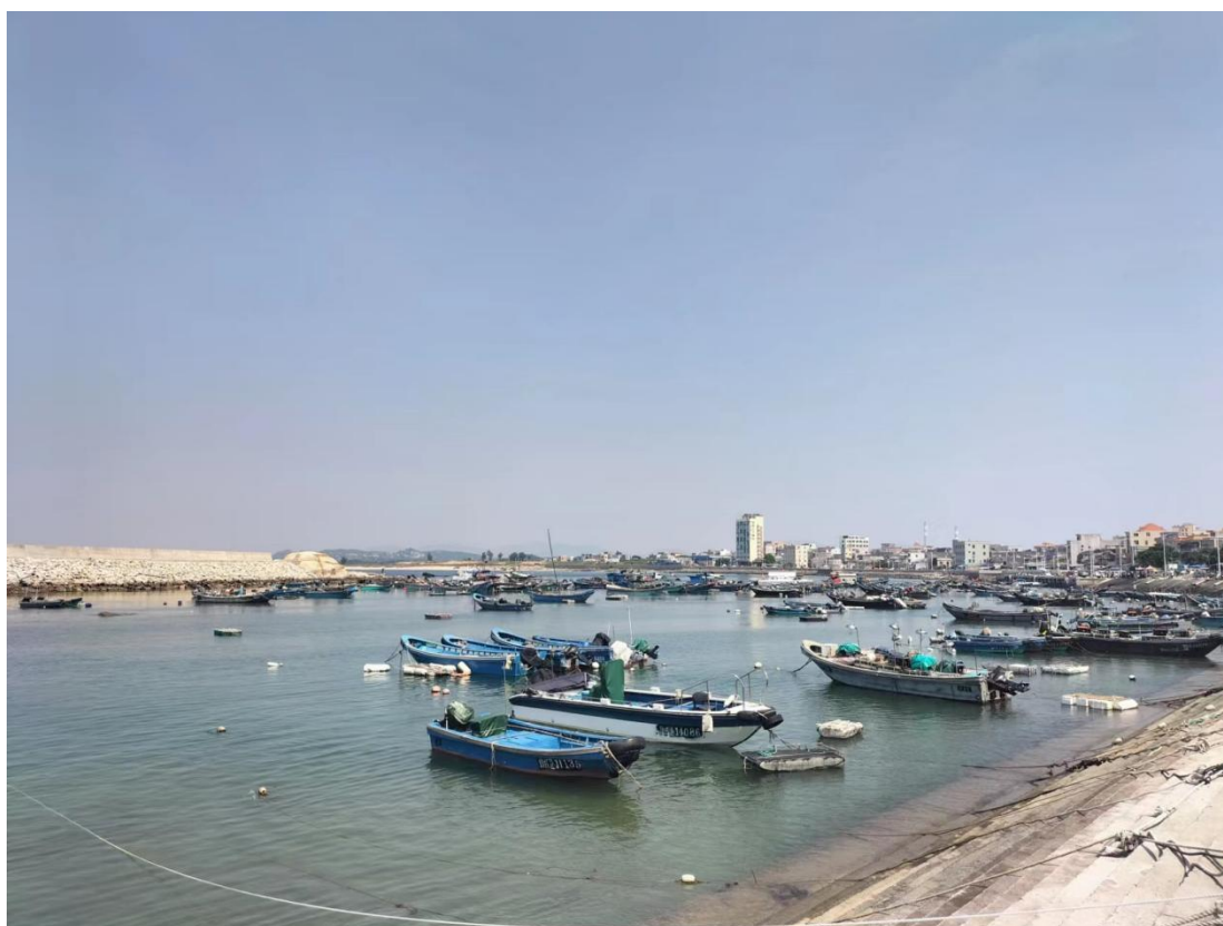
图 6.3.2-3 遮浪渔港一期工程
