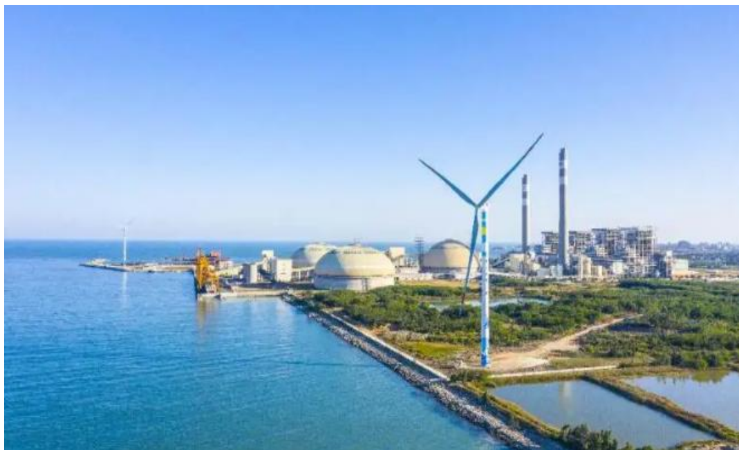
图 6.3.2-4 广东汕尾电厂一期工程
