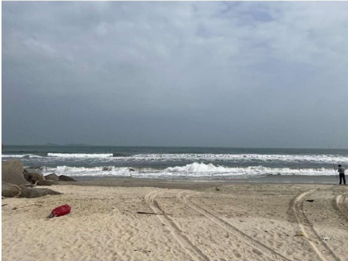
图 3.2.4-11 污水排海管道下海点现场图
