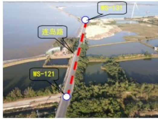
照片 8: 节点 WS-121~WS-131 连岛路段 (开挖施工)
