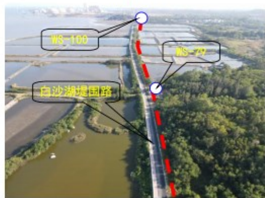
照片 6: 节点 WS-68~WS-100 白沙湖堤围路 段 (开挖施工)
